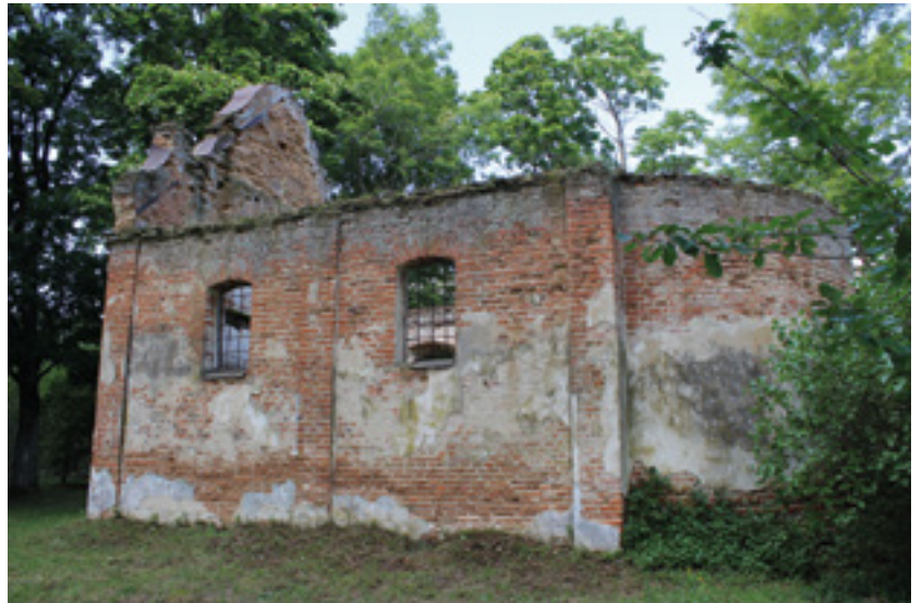
Ruiny kościoła pw. Św. Ducha w Jażwinach (Winczu). Elewacja boczna. Stan obecny
