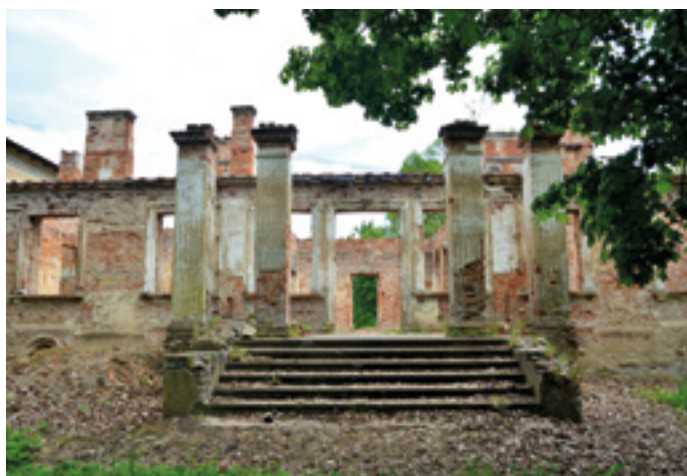
Dwór Dziekońskich – elewacja frontowa
