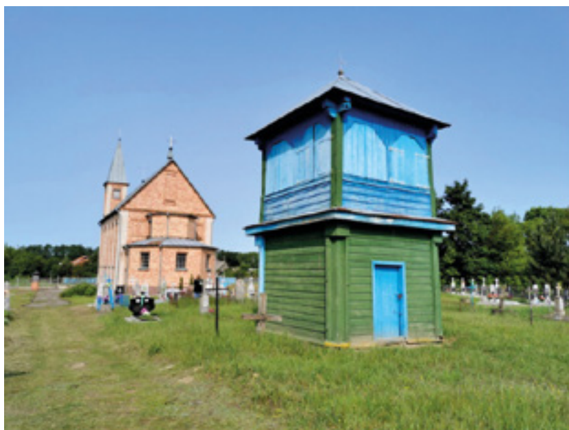
Zachowana drewniana dzwonnica w Osowie, która kiedyś stała obok zniszczonego kościoła. Stan obecny
