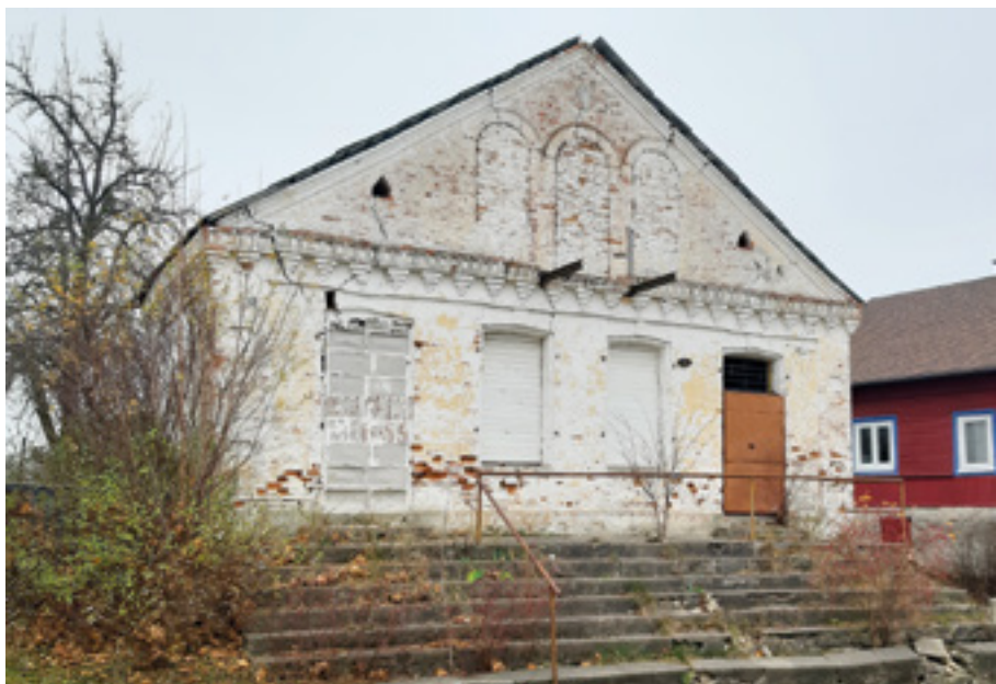
Murowany budynek byłej kramy żydowskiej
