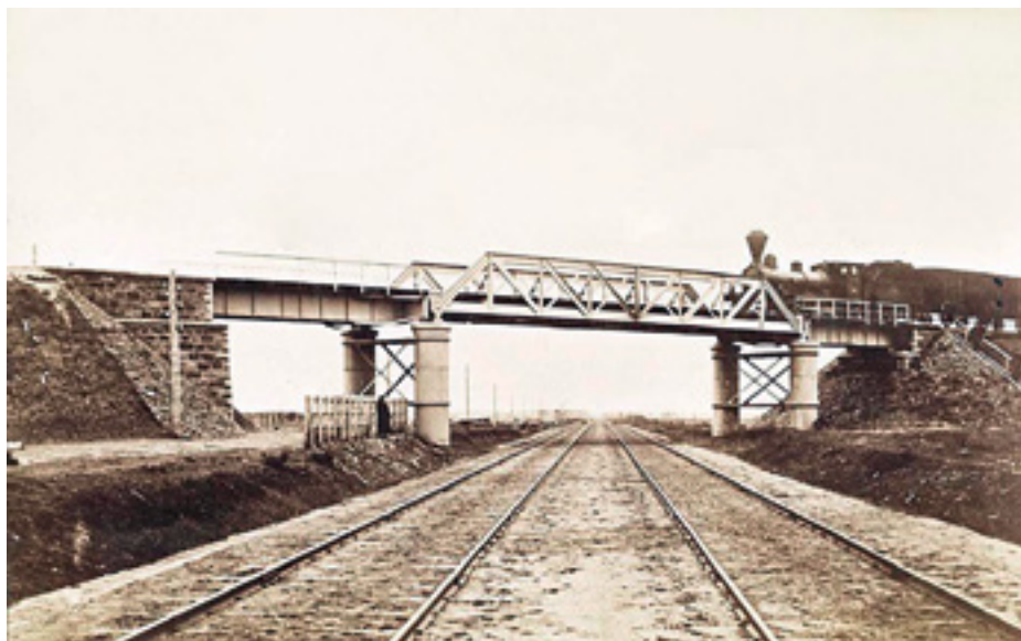
Wiadukt na skrzyżowaniu kolejowym Moskwa-Brześć i Baranowicze-Białystok
