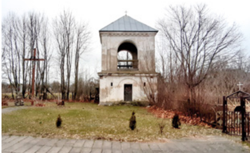
Dzwonnica. Stan obecny
