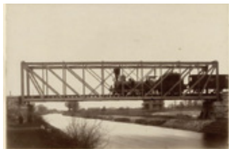
Most kolejowy przez Kanał Królewski. Koniec XIX w.
