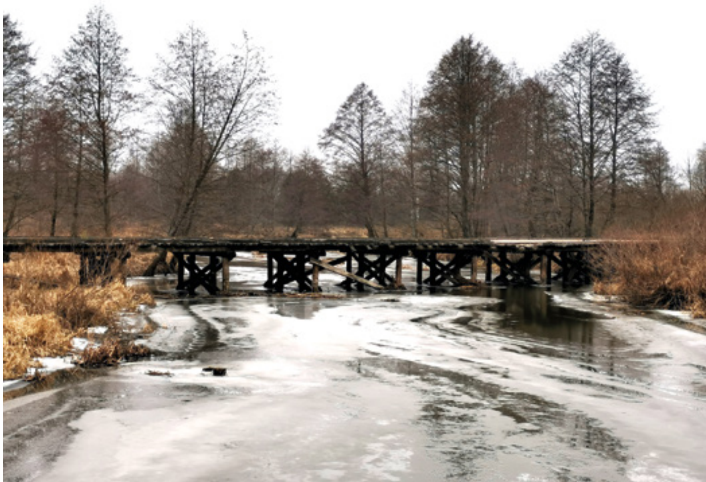
Zabytkowy (obecnie nieczynny) most nad Szczarą w okolicach Reginowa
