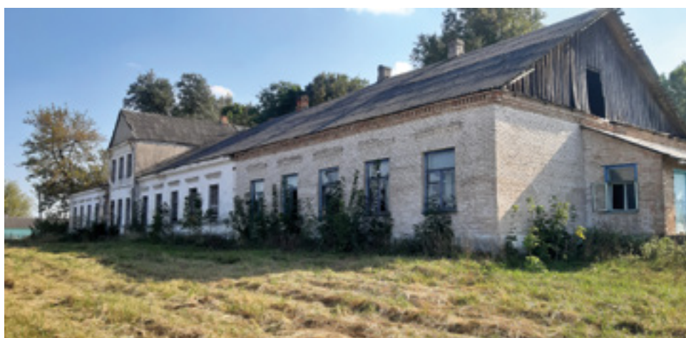
Elewacja ogrodowa dworu z dobudowanym skrzydłem
