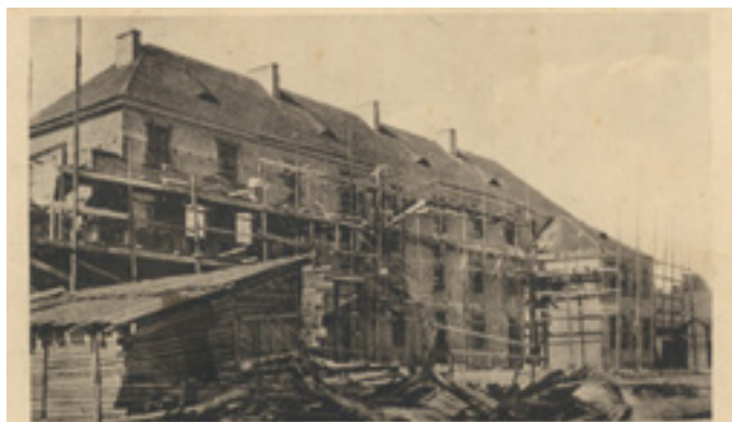
«Gmach Szkoły Powszechnej w budowie – zdjęcie wykonane w 1930 roku przez A. Wysockiego, nauczyciela Gimnazjum w Łuninie.»
