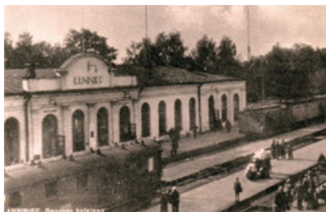
Dw. kolejowy w Łunińcu
