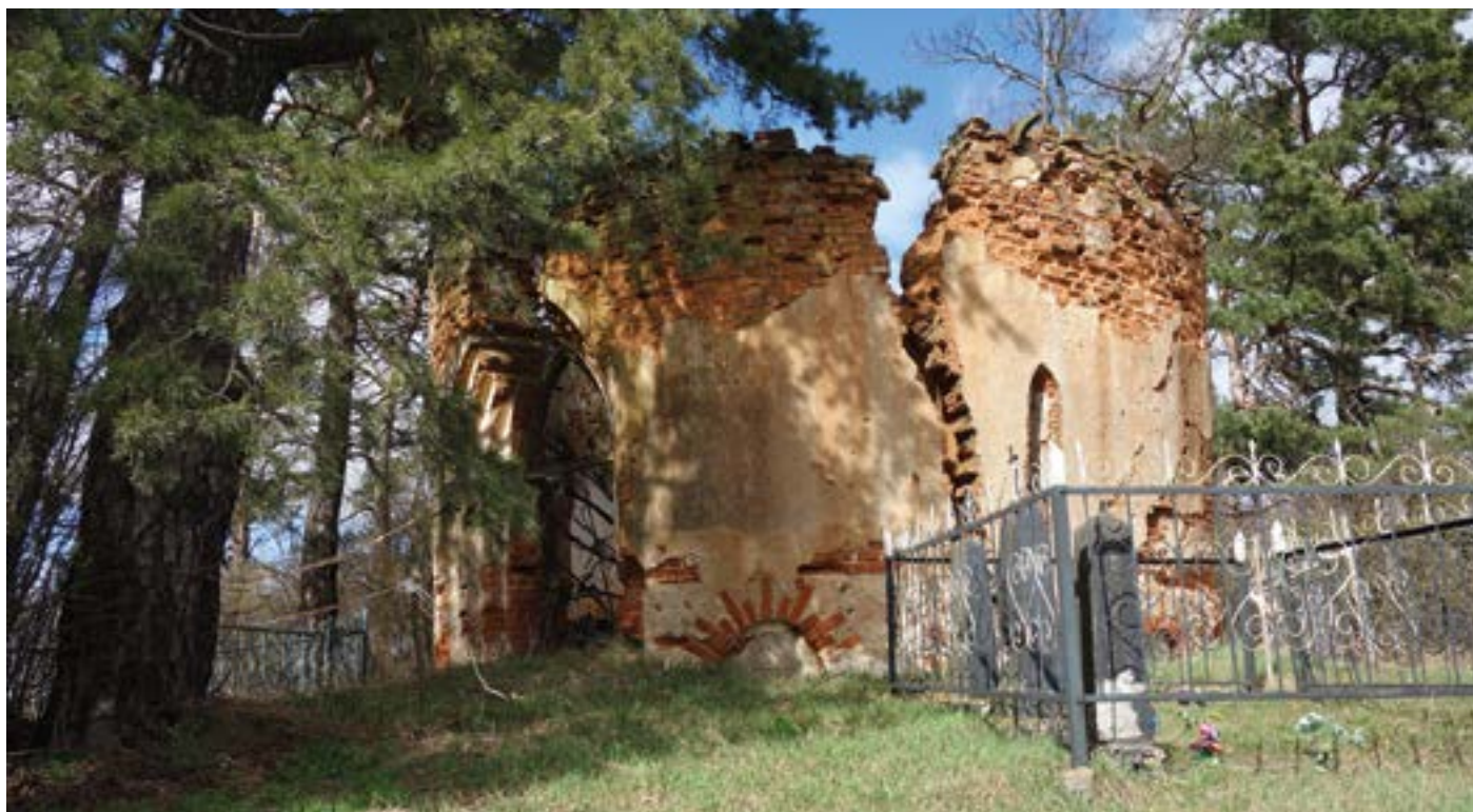
Pozostałości kaplicy cmentarnej w Bartnikach
