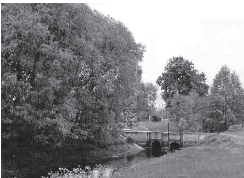
Śluzę na kanale zastąpił wodny przepust. W głębi za drzewami, widać fragment budynku przedwojennego Kierownictwa Eksploatacji Kanału.
