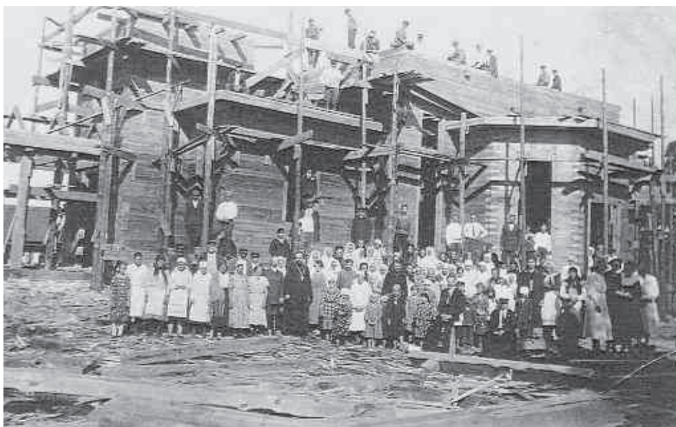
Budowa cerkwi w Telechanach.
